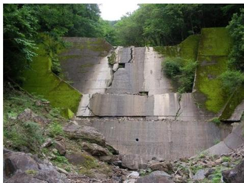
図2 地すべりによって被災した谷止工(宮崎県椎葉村)
