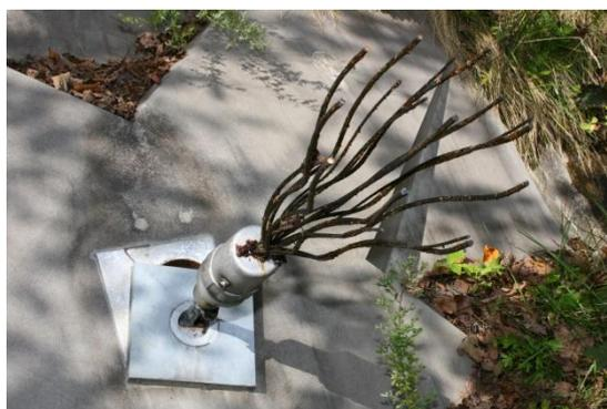
図 15 地震によって破壊されたアンカー工（岩手県奥州市）
