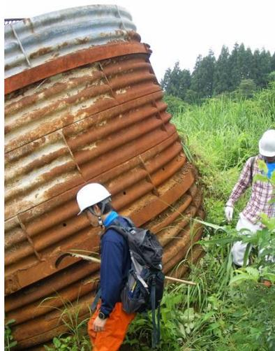
図1 地すべりの再活動によって傾倒した昭和50年代に施工された集水井
