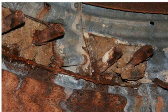
図5 地すべりの移動と電蝕によって腐蝕した集水ボーリング(佐賀県唐津市)
