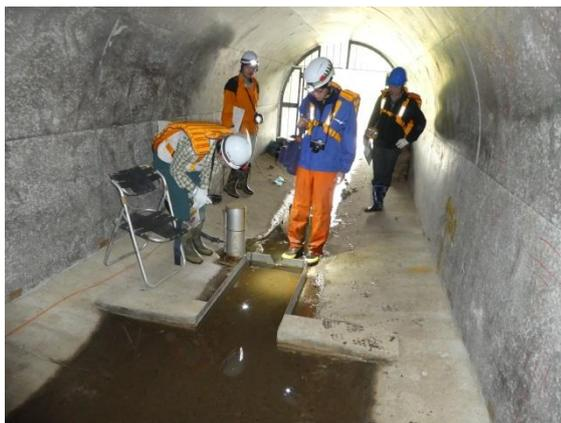
図17 概成後の排水トンネルに設置された流量計（新潟県上越市）
