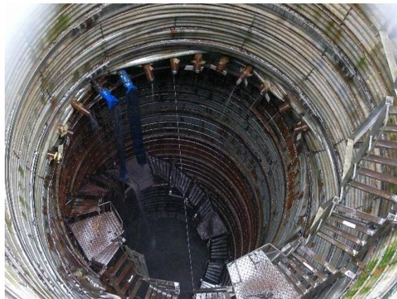
図 1 融雪期に水没し、地すべりの再活動によって被災した集水井（富山県）
