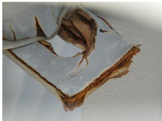
図7 エポキシ樹脂を塗布したにもかかわらず 集水井に発生した腐蝕(熊本県市南阿蘇村)
