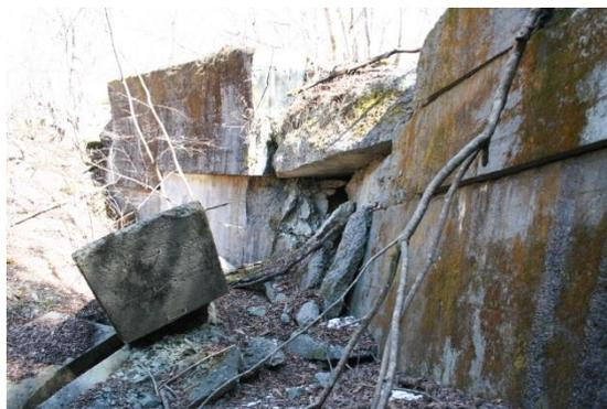
図3 地すべりによって破壊された谷止工(長野県大鹿村)
