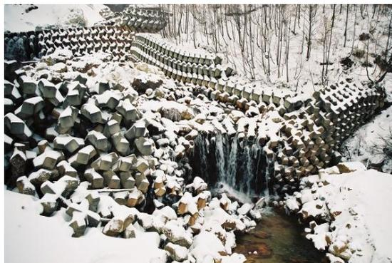
図4 地すべりによって破壊された谷止工(福島県米沢市)
