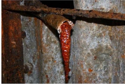
図8 保孔管の腐蝕とスライムの付着(秋田県北秋田市)
