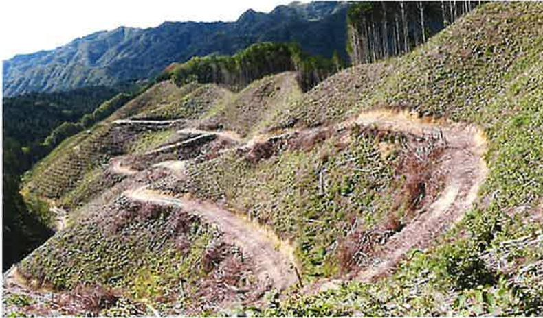
写真 3.71 切り盛り土工と丸太打ち込み・枝条積み上げによる路肩保護（茨城署）
