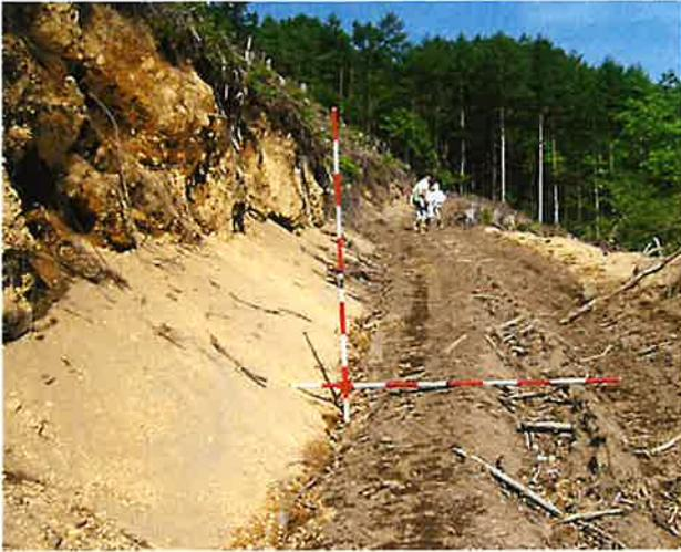
写真 3.76 崩落土砂によるのり面脚部の崖錐堆積（吾妻署）
