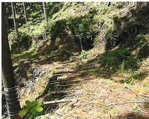
写真 2.31 丸太敷設路面と山側崩落
