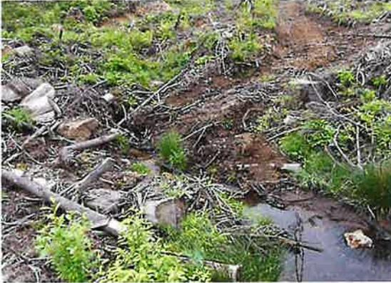
写真 2.12 丸太敷設による横断排水
