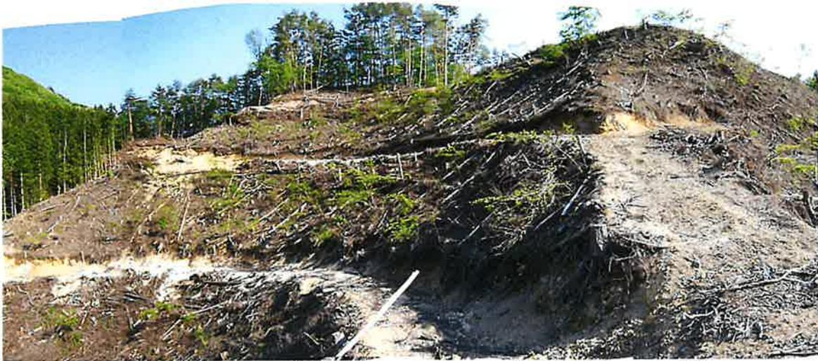
写真 3.68 等高線状に 20m前後の間隔で作設された作業道（利根沼田署）
