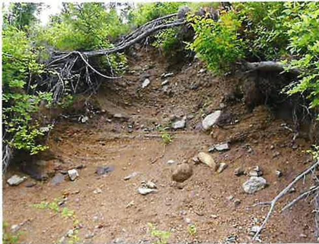
写真 2.4 法頭上部が崩落し浮き上がった根株
