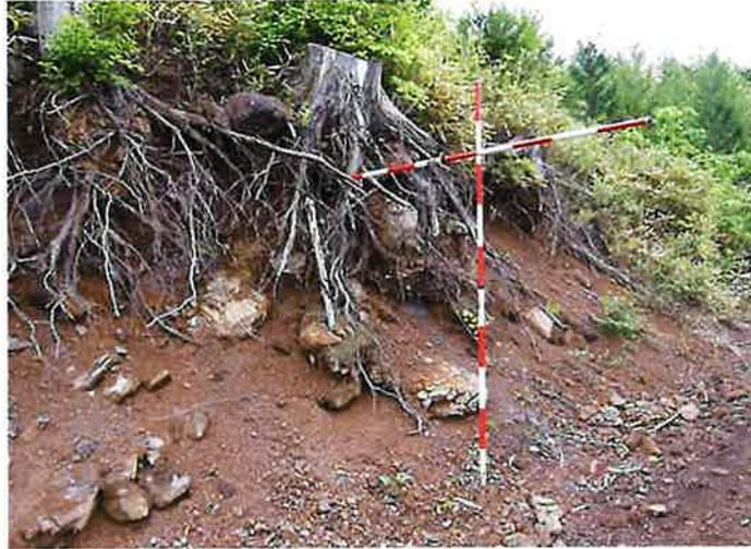
写真 2.3 切り取り斜面上部の浮き上がった根株
