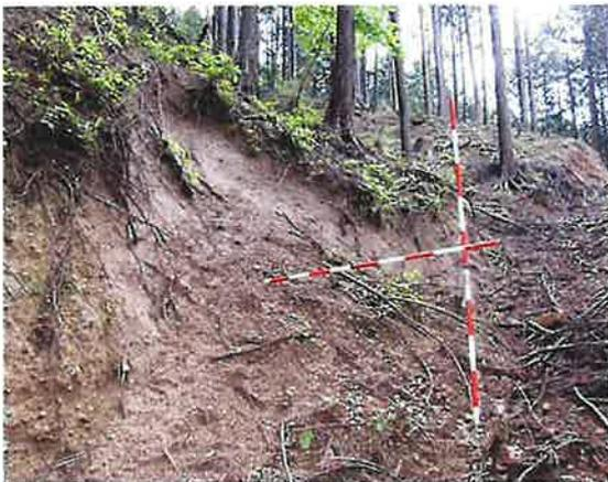
写真 2.39 法頭からの崩落状況
