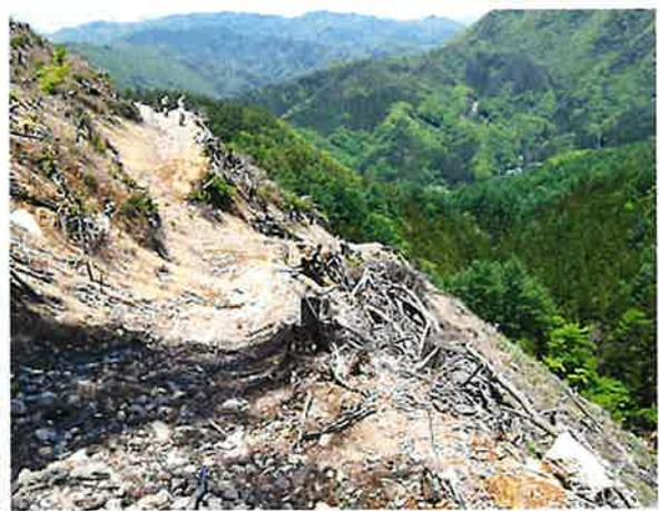
写真 3.70 写真 3.69 崩壊地源頭部の路体決壊
