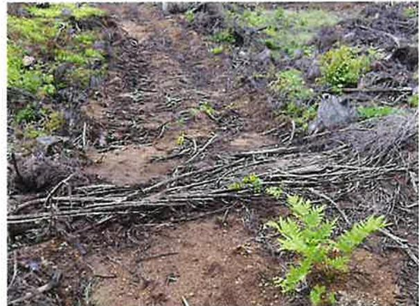
写真 2.17 丸太と枝条敷設の横断工
