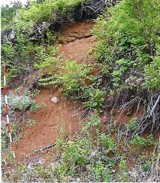
写真 2.5 法頭上部が崩落
