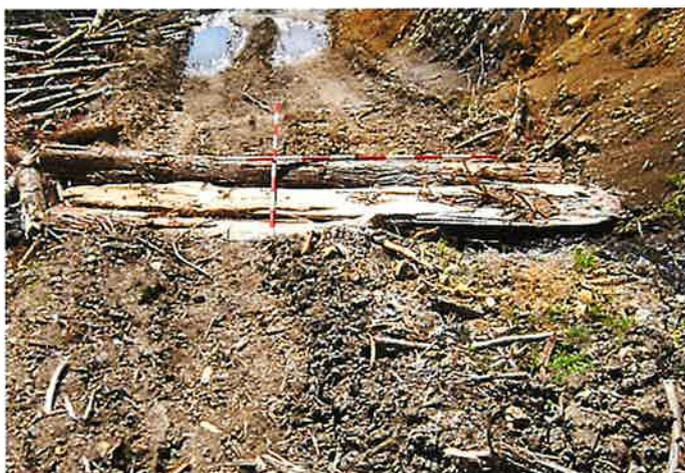
写真 3.87 丸太と半割材による横断排水溝 (利根沼田)
