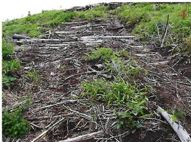
写真 3.86 丸太や枝条を敷設した路面侵食防止対策 (塩那署)
