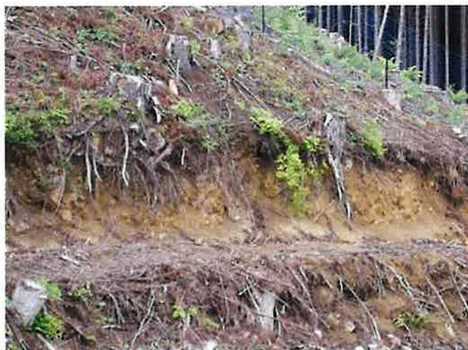
写真 2.18 伐根が浮き上がった状態の切り取りのり面
