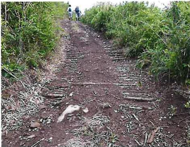
写真 2.1 25~30%区間での丸太敷設路面
