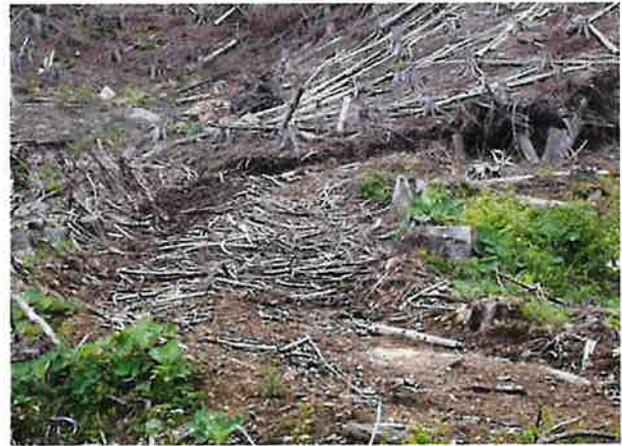
写真 2.14 枝条散布で侵食防止を図った路面
