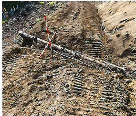
写真 3.88 素掘り横断溝に丸太を敷設 (吾妻署)
