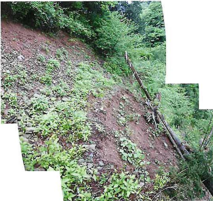
写真 2.26 路体崩落状況と山側切り取り面
