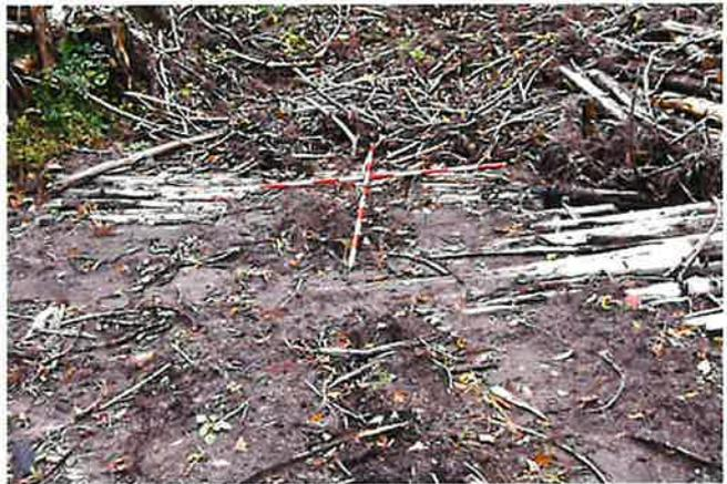
(2) 丸太洗い越しと枝条散布路面
