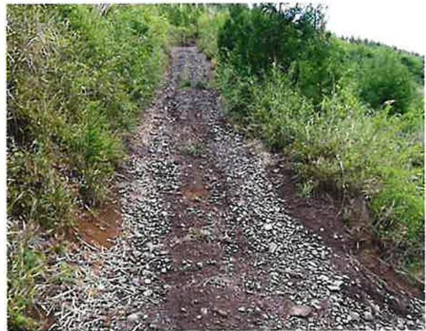
写真 2.2 延長約 50mの敷砂利路面
