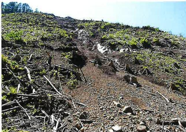
写真 3.69 3 段の作業道を崩落させた崩壊地
