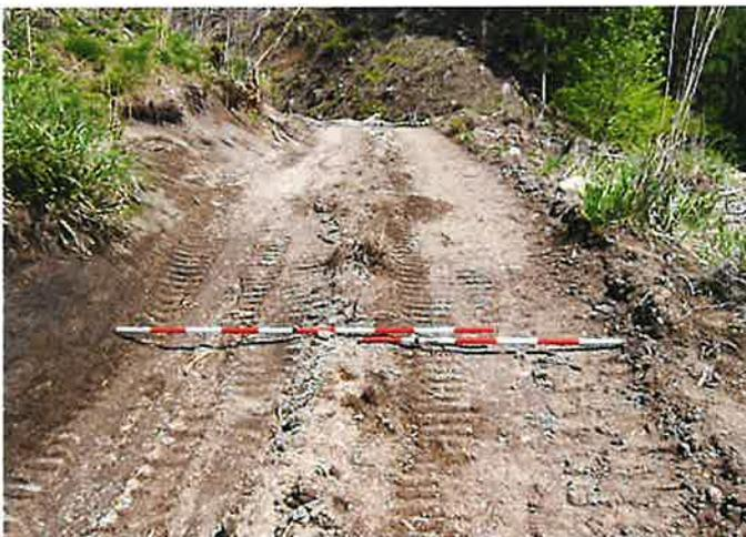
写真 3.74 作業道幅員 2.6m
