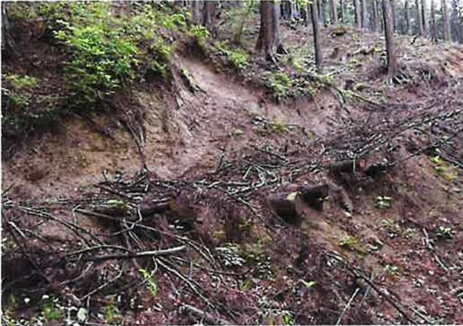
写真 2.38 丸太と根株による路体補強対策箇所
