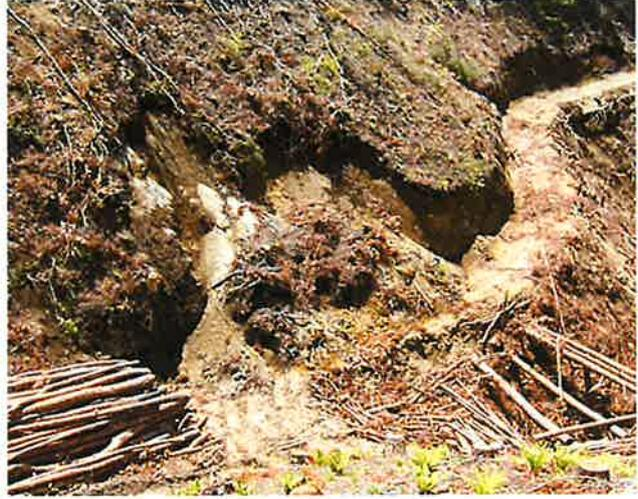
写真 3.77 切取面上部からの崩壊
