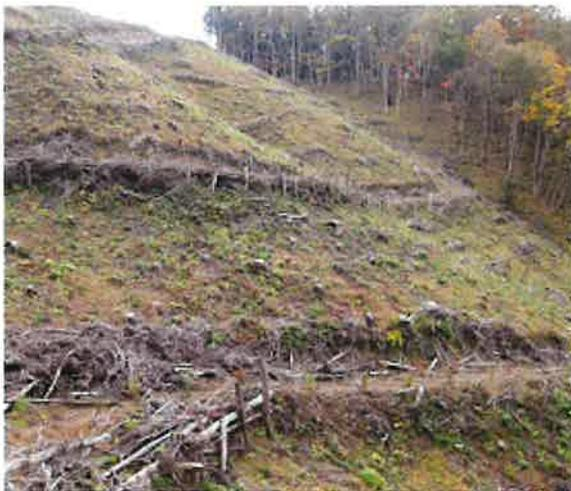
写真 3.73 路肩部の丸太杭と丸太、枝条による柵工（磐城署）
