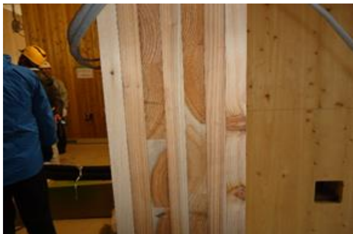
写真 33 CLT の断面
