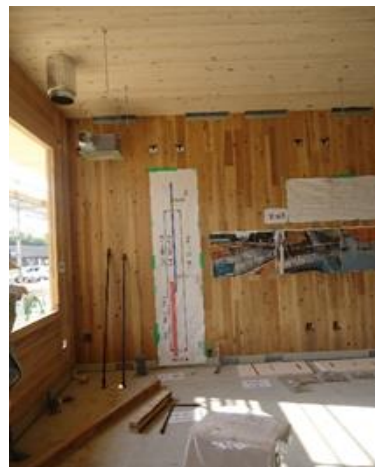
写真 34 CLT による壁
