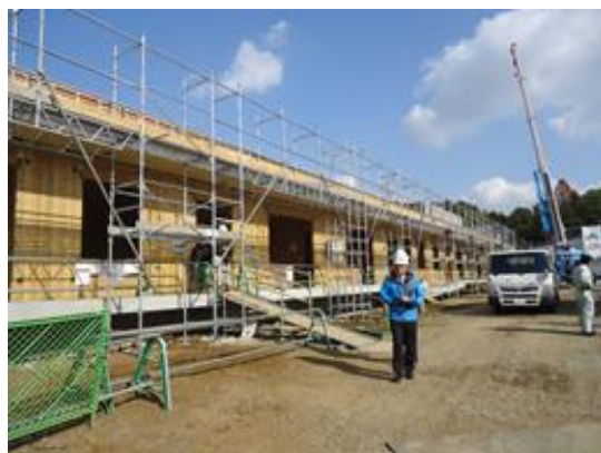
写真 35 CLT を使った実験棟
