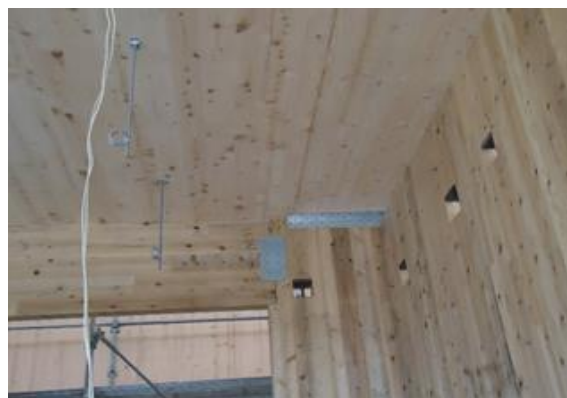
写真 36 CLT の天井部分
