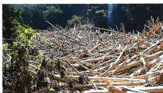
図 4.9.21 筑後川水系妙見川における不透過型砂防堰堤による流木の捕捉
