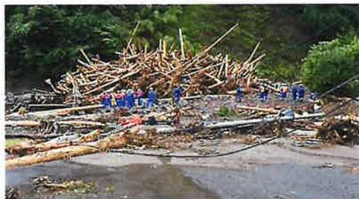
図 4.9.19 筑後川水系大肥川支川宝珠山川における流木による橋梁の閉塞
