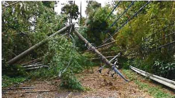
図 4.11.7 電柱・電線への被害
