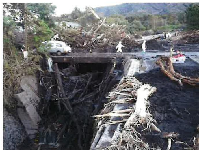
図 4.9.5 流木による橋梁の閉塞と土石流・流木の氾濫
