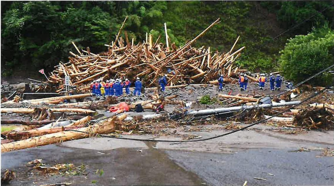
図 10.10.5 流木による閉塞された橋梁（平成 29 年 7 月九州北部豪雨，福岡県東峰村，大肥川支川宝珠山川）
