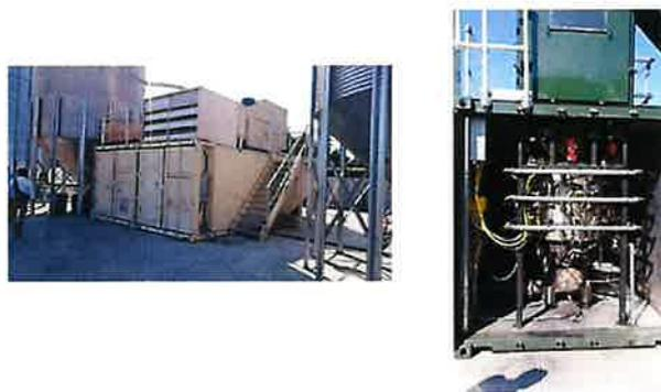
小型木質バイオマスガス化発電給熱装置
