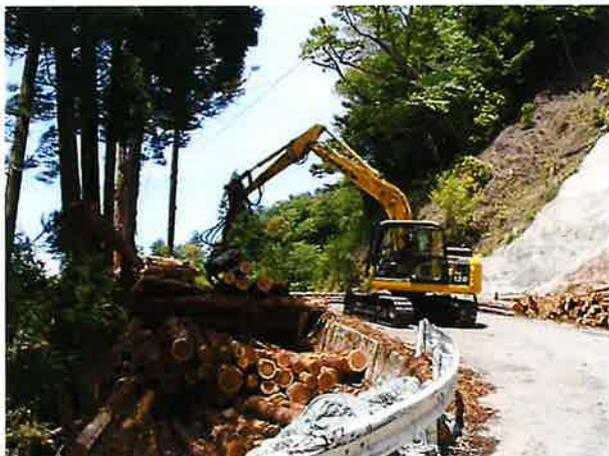
図 3-58 プロセッサによる造材の状況
