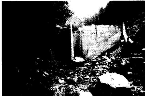
図 7.1.7 中尾谷川の治山ダムの破損状況
