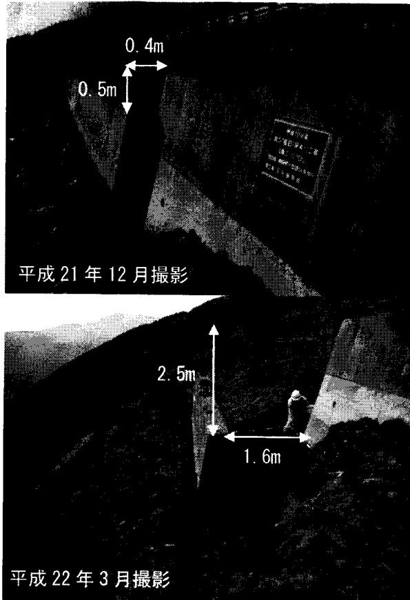
図 7.2.2 平成 18 年設置コンクリート土留工（3 段目）の変状
