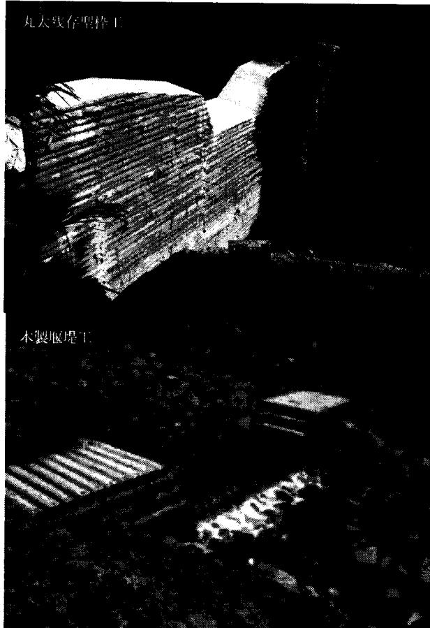
図 8.2.1 木材を用いた治山堰堤工の事例
