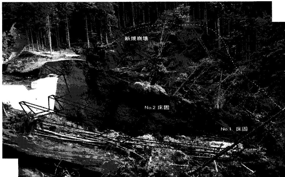
図 2. 3.17 左岸浸食崩壊により被災した谷止工・床固工
