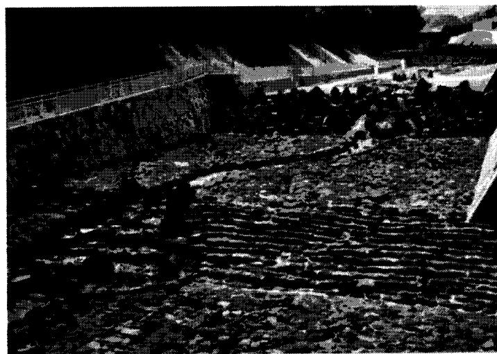
自然地への同化をはかるうえで、対象場の性格を十分に調査し、基本的にはその性格を踏襲する景観づくりが適切である。写真的のケースでは自然の変動に対応しきれず、過剰なデザイン性が目立ってしまっている。
