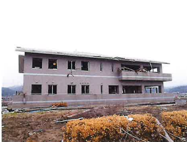
松原の後部にある浄化センター建物
