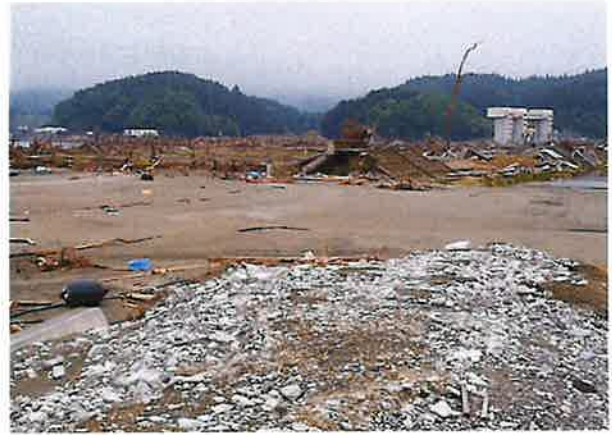
破壊された林内の防潮堤
