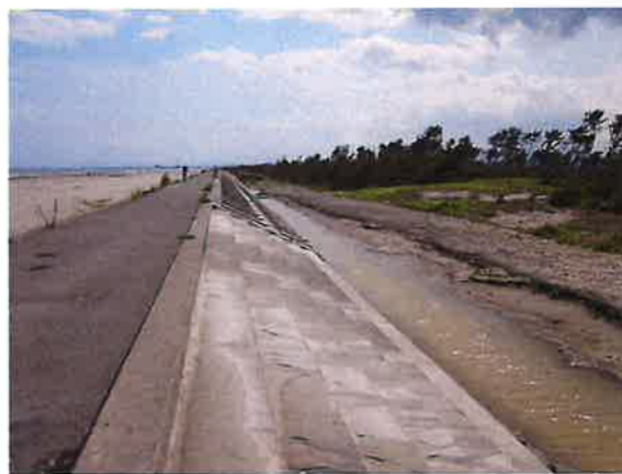
写真 13 堅牢な防潮堤
