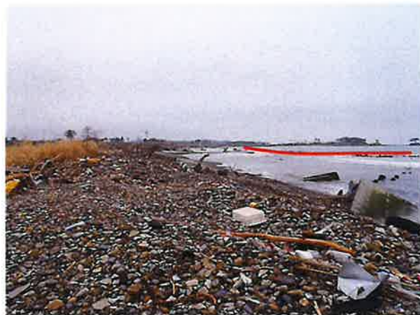
地盤沈下、侵食により汀線が後退
