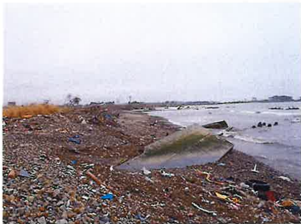
破壊された防潮堤
