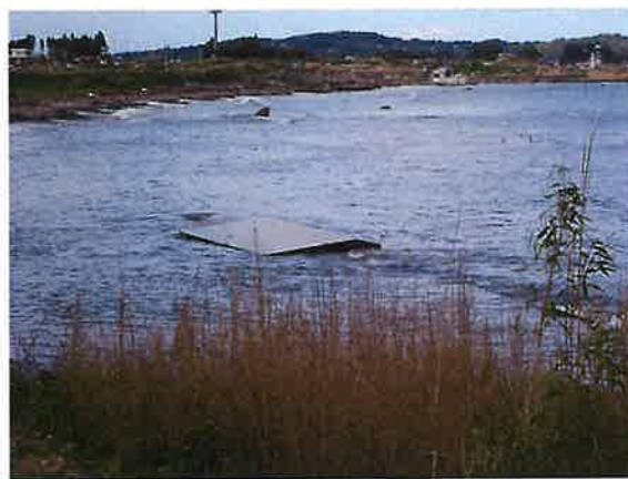
写真9 転倒した防潮堤
