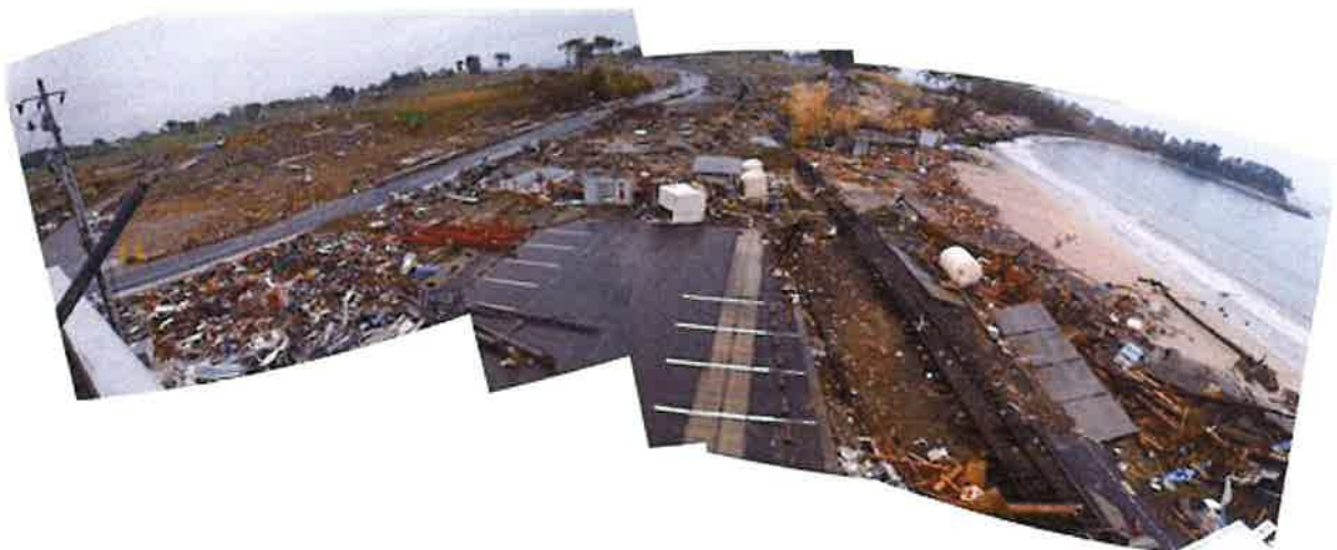
海岸林が跡形もなく破壊されている（元々林帯幅が狭い部分）
