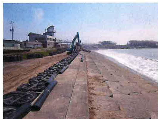
写真4 海岸林除去後 (2011. 8. 9) ※撮影位置が測量縦断線
