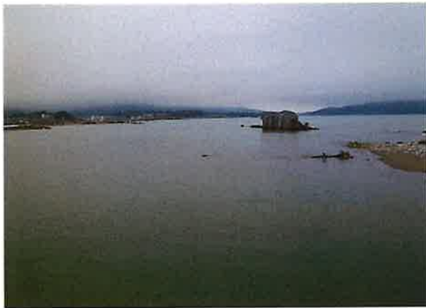
海中に残った防潮堤の水門
