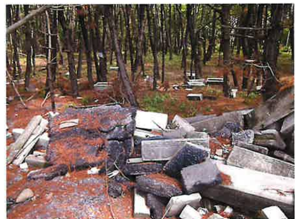
写真7 林内に散乱する防潮堤のブロック
