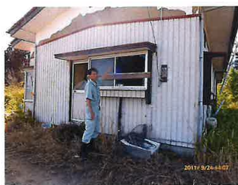
写真 14 居久根の外側の被災の様子 (2m 近く浸水した跡があった)
