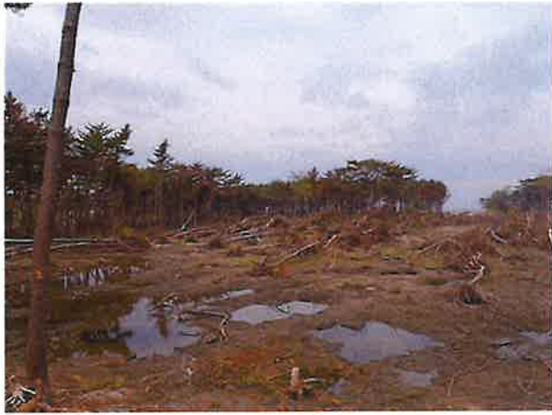
一部冠水（貞山堀より後部）
